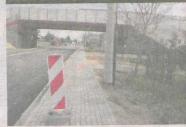
Przebudowa ulic Glinki, Wodnej i Leszczyce ma potrwać do końca marca
