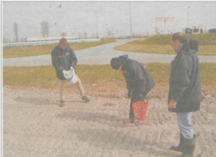
Oczyszczalnia w Chwałkowie
