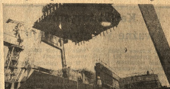
Na pochylniach Stoczni Szczecińskiej im. A. Warskiego trwają prace przy budowie kilku typów jednostek dla armatorów zagranicznych. Statki te to: kontenerowce (na zdjęciu — wstawiane poszycia do kadłuba stojącego na pochylni) i masowiec z serii 33 500 DWT. Prowadzą się również roboty przy budowie promu dla Polskiej Żeglugi Bałtyckiej. CAF — fot. Undre
