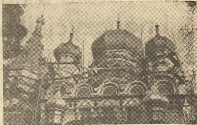
W Hrubieszowie (Zamojskie) trwają prace konserwatorskie przy cerkwi pochodzącej z końca XIX w. W przyszłym roku obiekt ten ma być udostępniony zwiedzającym. Na zdjęciu: — fasada zabytkowej cerkwi.
