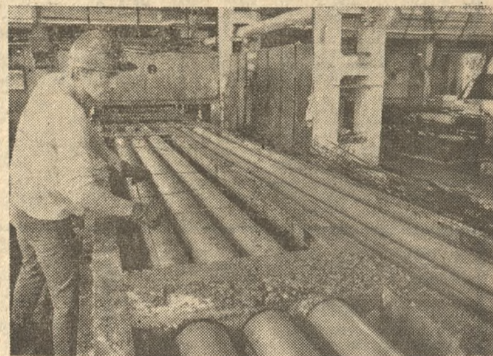
Do budynków mieszkalnych sporo potrzeba elementów, wytwarzanych w Zakładzie Produkcji Betonów „Jastrobet” w Jastrowiu (Pile). Nie nadają one jednak zaspokajaniem tych potrzeb. Na zdjęciu: zbrojenie płyt stropowych.
