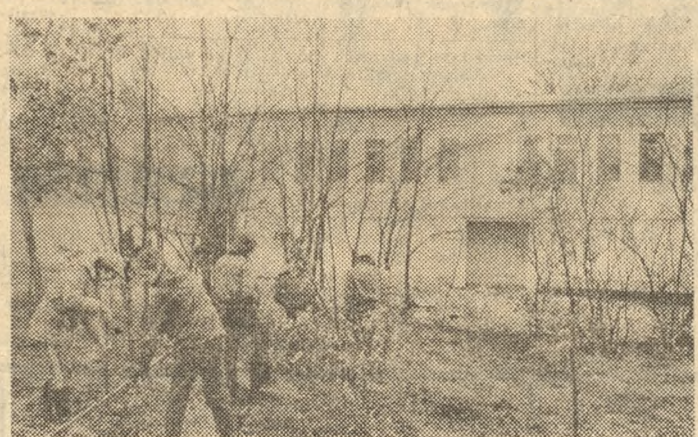
Uczniowie Zespołu Szkół Rolniczych w Tarcach (województwo kaliskie) otrzymają za kilka dni nową salę gimnastyczną. Obok tej sali w piętrowym łączniku będą: szatnia, biblioteka i sala tradycji szkoły. Obecnie trwają ostatnie prace wykończeniowe. W budynku pracują stolarze a uczniowie — jak widać na zdjęciu — porządkują teren.
