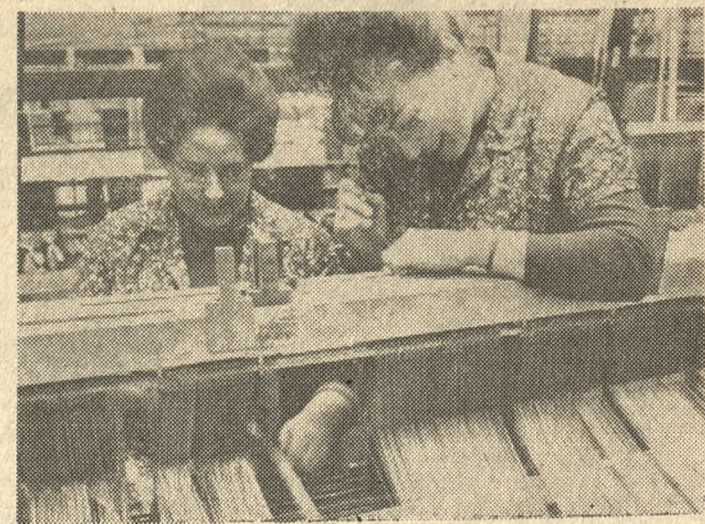
Ręczne przewlekanie osnów wymaga w „Wistilu” niemal zegarmistrzowskiej precyzji.
