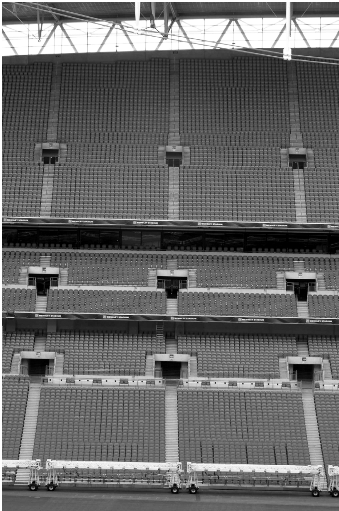
Fot. 4-1. Stadion Wembley (2008) – fragment widowni. Widoczny układ komunikacji i ewakuacji na poszczególnych piętrach trybun. Zróżnicowane szerokości wómitoriów decydują o różnych czasach ewakuacji osiąganych w obsługiwanych przez nie sektorach widowni.
