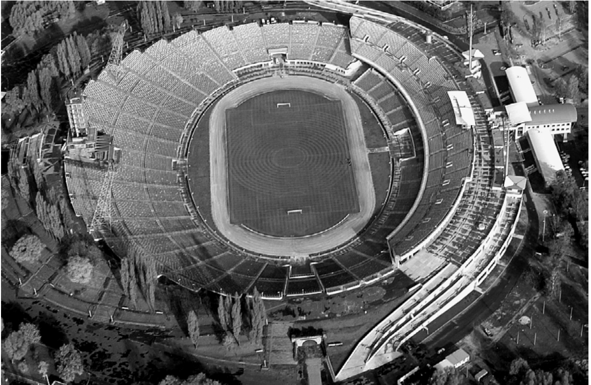
Fot. 1-37. Stadion Śląski – widok ogólny od strony południowej; stan z roku 2006. Po prawej stronie widoczne pochylne komunikacyjno-ewakuacyjne obsługujące widownię wschodnią. Pod widownią wschodnią znajduje się zespół pomieszczeń o łącznej powierzchni 18 tys. m 2 . Pojemność widowni wynosi ok. 47 tys. miejsc siedzących.
