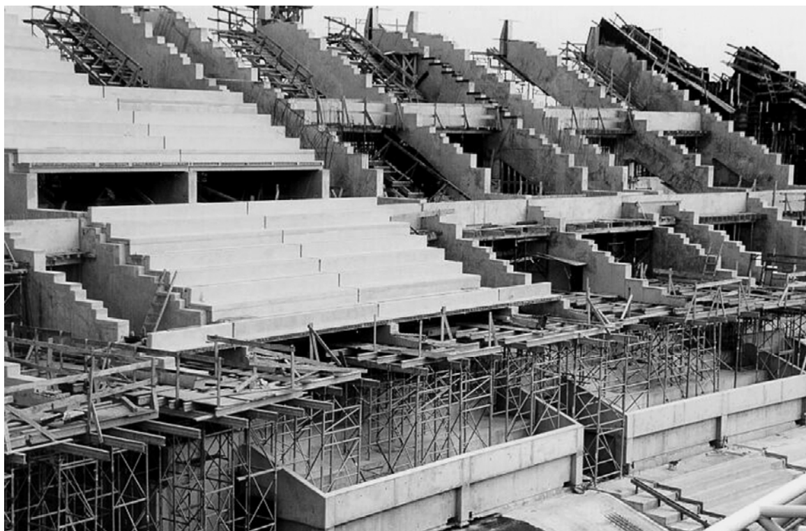
Fot. 5-2. Stadion Śląski-budowa widowni wschodniej (2001). Widoczny fragment żelbetowej konstrukcji widowni górnej. Każdemu sektorowi odpowiada oddylatowany moduł konstrukcyjny składający się z trzech rygli. Projektowany profil widowni uzyskiwany jest dzięki odpowiedniej geometrii tworzących powierzchnię trybun prefabrykatów i wycięć w górnej krawędzi rygli. Foto: Z. Pelczarski.
