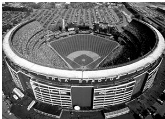
Fot. 1-30. Shea Stadium , Nowy York (1964-2008). Przykład nieistniejącego już stadionu, należącego do grupy stadionów dwufunkcyjnych (futbol amerykański i bejsbol), z widownią kołową i przestawialną widownią dolną. Na zdjęciu po stronie lewej – aranżacja areny dla funkcji piłkarskiej, po prawej funkcja bejsbola. Foto: http://www.ballparks.com , 2007.
