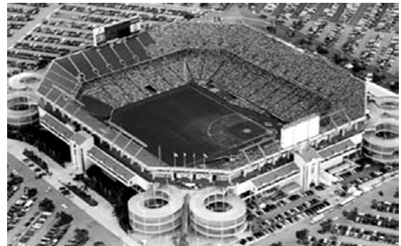
Fot. 1-13. Przykładowe stadiony z terenu Stanów Zjednoczonych reprezentujące nurt uproszczonych, graniastych form przestrzennych, wykorzystujących wielopiętrowe widownie prostokątne o profilach prostoliniowych. Główną motywacją stosowania takich rozwiązań były względy ekonomiczne i łatwość realizacji. Charakterystycznym dla tych aren elementem są pochylne – zastępują one schody, uznane za bezpieczne podczas ewakuacji i przy masowym ruchu widzów.
