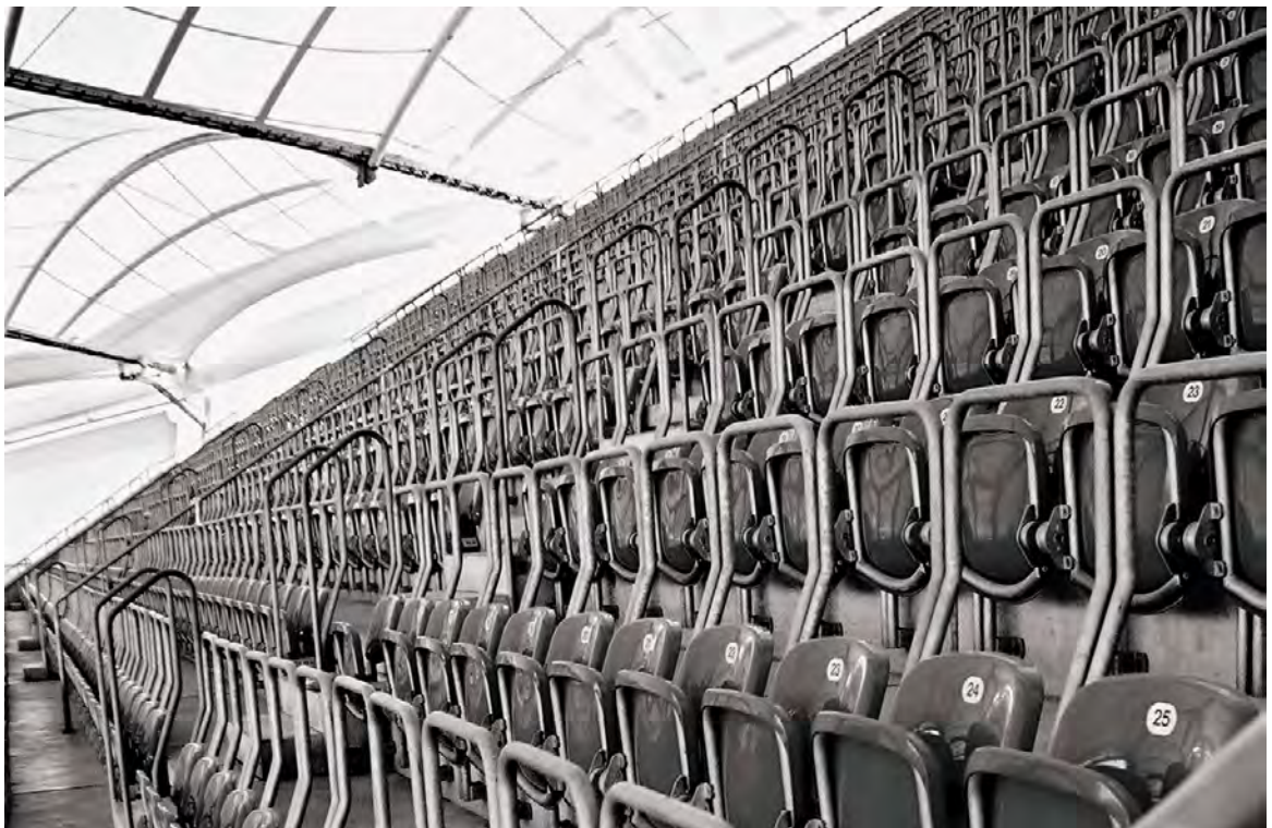
Fot. 3-4. Gottlieb-Daimler Stadion, Stuttgart – nowa trybuna zachodnia (2005). Przykład stromej widowni o profilu prostoliniowym wyposażonej w system balustrad w każdym rzędzie. Element tworzący balustradę stanowi integralną część konstrukcji siedziska. Jest to patent firmy S&H, która zaopatrzyła w siedziska zmodernizowaną widownię Stadionu Śląskiego w Chorzowie. Foto: M. Pelczarski.
