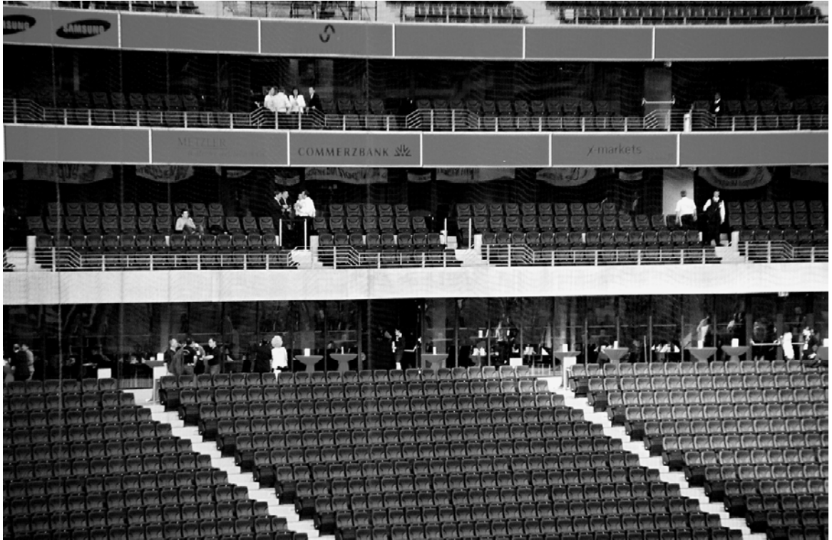
Fot. 1-27. Fragment widowni zachodniej Commerzbank Arena we Frankfurcie. Trzy poziomy miejsc specjalnych, zaprojektowanych pomiędzy widownią dolną i górną. Na najniższym poziomie umieszczono restaurację z tarasem wyeksponowanym na wnętrze stadionu, dwa wyższe poziomy stanowią ciąg indywidualnych łóż z zapleciami. Foto: autor.
