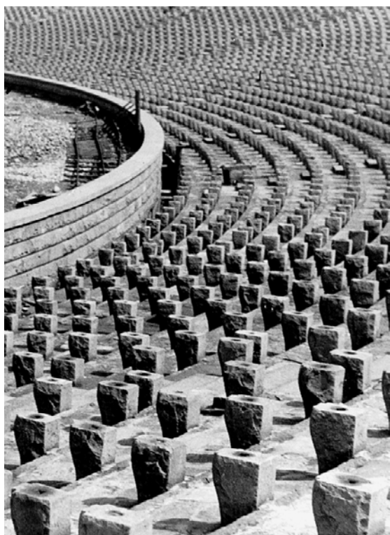
Fot. 1-35. (po lewej) Stadion Śląski- budowa trybun ziemnych (1955). Zdjęcie przedstawia ostatnią fazę robót przed zamontowaniem drewnianych ławek. Słupki z piaskowca występowały w rozstawie co 1m.
