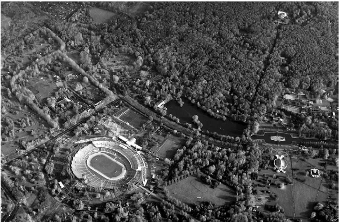
Fot. 1-38. Stadion Śląski i jego otoczenie (2006). Powiązanie kompozycyjne Stadionu i otaczającego go Parku (600 ha), stanowiło podstawową zasadę zarówno projektu pierwotnego, jak i projektu modernizacji. Stadion Śląski należy do nielicznej grupy stadionów krajobrazowych, a o jego walorach w znacznej mierze decydują harmonijne relacje jego wnętrza z funkcjonalną i przestrzenną strukturą Parku.
