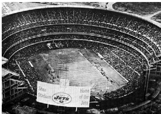
Fot. 1-30. Shea Stadium , Nowy York (1964-2008). Przykład nieistniejącego już stadionu, należącego do grupy stadionów dwufunkcyjnych (futbol amerykański i bejsbol), z widownią kołową i przestawialną widownią dolną. Na zdjęciu po stronie lewej – aranżacja areny dla funkcji piłkarskiej, po prawej funkcja bejsbola. Foto: http://www.ballparks.com , 2007.
