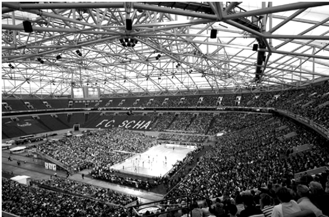
Fot. 1-18. Veltins Arena, Gelsenkirchen. Przykład areny wielofunkcyjnej. Pełne zadaszenie stadionu oraz ruchoma, wysuwana na zewnątrz płyta boiska, umożliwia realizację funkcji innych niż piłka nożna. Zdjęcie przedstawia mecz piłki ręcznej, przy organizacji którego wykorzystano połowę stałej widowni stadionu i składaną trybunę pomocniczą, ustawioną na płycie areny. Foto: http://www.stadionwelt.de (2005).
