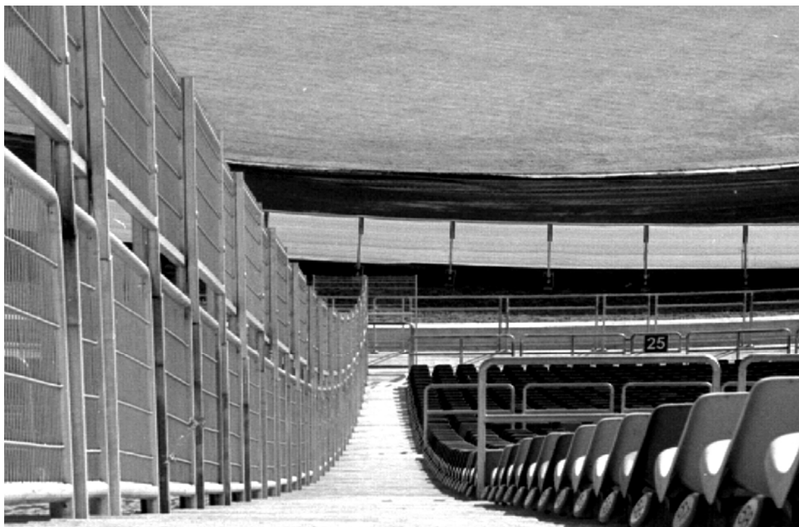
Fot. 2-10. Stadion Śląski, Chorzów, (1997). Widownia zachodnia. Przykład widowni łukowej o profilu krzywoliniowym. Widok w kierunku areny – wyraźnie widoczna krzywa paraboloidalna profilu. Po lewej rozbiegająca bariera bezpieczeństwa pomiędzy megasektorami. Foto: autor.
