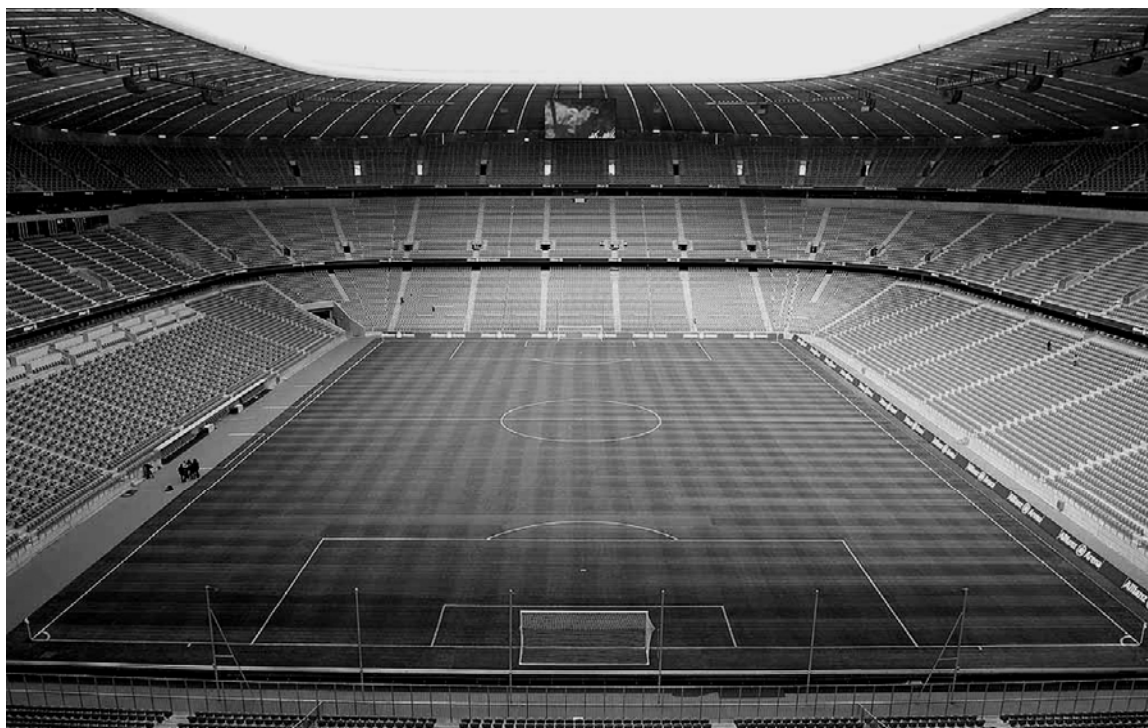
Fot. 1-19. Allianz Arena, Monachium. Zdjęcie dobrze odzwierciedla rzeczywisty charakter wnętrza dużego, współczesnego stadionu piłkarskiego. O charakterze tym decydują: prostokreślność widowni, prostoliniowy profil poszczególnych pięter trybun, duże nachylenia tego profilu i znaczne wyniesienie najdalszego rzędu. Dodatkowym elementem wpływającym na percepcję wizualną tego wnętrza, zwłaszcza w zakresie odbioru jego proporcji, jest welariowe podniebienie zadaszenia.
