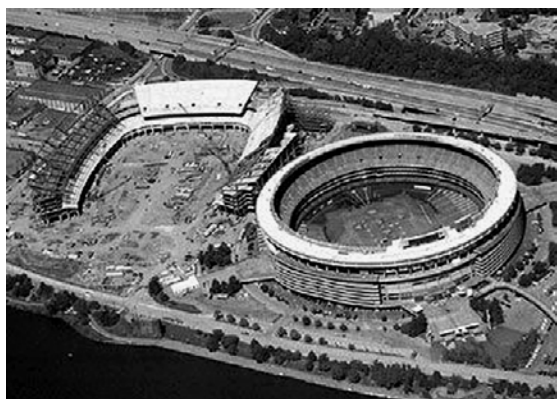
Fot. 1-31. Three Rivers Stadium , Pittsburgh, Pennsylvania (1970-2001). Kolejny przedstawiciel licznej grupy amerykańskich stadionów dwufunkcyjnych z widownią kołową i przestawialną widownią dolną. Zdjęcia przedstawiają charakterystyczną dla Stanów Zjednoczonych tendencję burzenia wyeksploatowanych w ciągu 30-45 lat stadionów i budowania, zazwyczaj tuż obok, nowych stadionów dla tych samych funkcji. Foto: http://www.ballparks.com , 2007.
