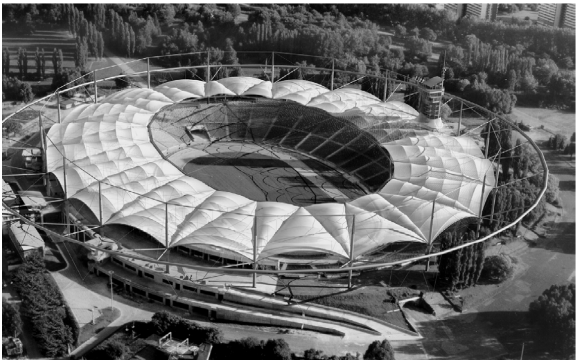
Fot. 1-40. Stadion Śląski – widok ogólny projektu zadania SATURN 2005. Konstrukcję wsporczą stanowi zespół dwudziestu słupów, w rozstawie co dwa sektory widowni. Poszycie połaci dachowej zaprojektowano z częściowo przezroczystej membrany PTFE, a w rejonie wieży z całkowicie przeźroczystej membrany ETFE. Membrana rozpięta jest na łukowych węgach stalowych, te z kolei wsparte są na dolnych cięgnach dźwigarów kablowych. Napięcie dźwigarów kablowych zapewniane jest dzięki sprężonemu pierścieniowi wewnętrznemu i sztywnemu pierścieniowi zewnętrznemu, stabilizowanemu za pomocą odciągów. Wizualizacja: M. Morga, archiwum ZPiW-TB.
