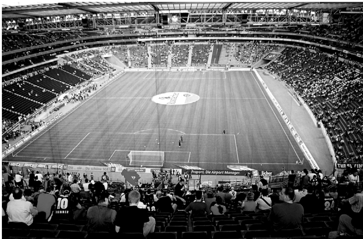
Fot. 2-3. Stadion Commerzbank Arena , Frankfurt, (2005). Przykład widowni łukowej o profilu prostoliniowym. Linie rzędów widowni przebiegają łukowo dzięki czemu, określona pozycja siedziska, oś anatomicznego pola widzenia nakierowana jest dośrodkowo, wykazując konwergencję z osią obrazu pola boiska. Widownie łukowe mają pod tym względem przewagę nad widowniami prostokreślnymi, które cechuje dywergencja obu tych osi. Foto: autor.
