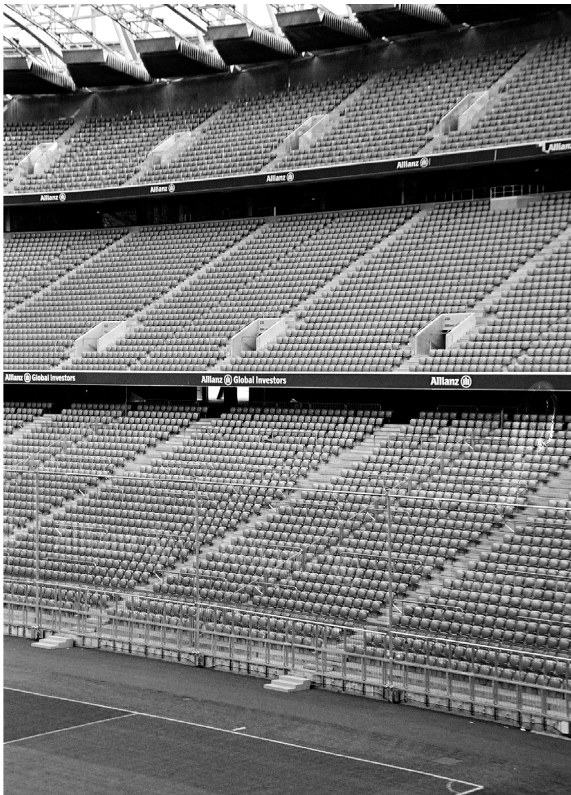
Fot. 2-9. Stadion Allianz Arena, Monachium, (2005). Przykład trzypiętrowej widowni o profilu prostoliniowym. W rzucie poziomym jest to widownia prostokreślna ze współśrodkowymi łukami w rejonie narożników boiska. Nachylenie trybun trzeciego piętra widowni wynosi 35^\circ , przy przewyższeniu linii widzenia fokusu Cx=8,2\text{cm} . Wyniesienie najwyższego rzędu osiąga wymiar ok. 40m. Uwagę zwraca oszczędny układ dróg komunikacyjno-ewakuacyjnych, którego parametry mają wpływ na wydłużone czasy ewakuacji. Pojemność widowni osiągnięta dla celów Mistrzostw Świata w Piłce Nożnej (2006) wyniosła 66 600 miejsc siedzących.
