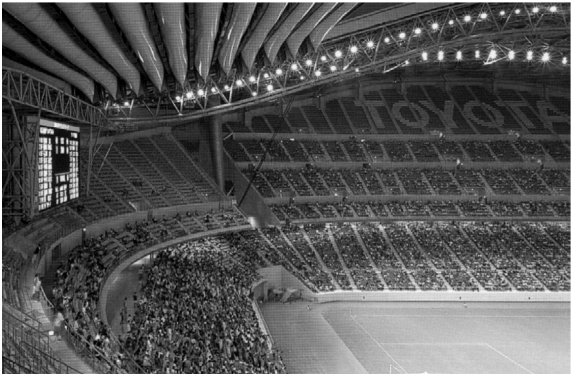
Fot. 4-9. Stadion Toyota, miasto Toyota. Przykład widowni o gęstym układzie schodów południkowych. Szerokość sektorów ograniczono do 14 miejsc w rzędzie, co jest charakterystyczne dla wszystkich japońskich stadionów przygotowanych na Mistrzostwa Świata w Piłce Nożnej Japonia-Korea 2002. Jest to efekt zaostzonych przepisów bezpieczeństwa, wynikających z zagrożeń wystąpienia trzęsień ziemi.
