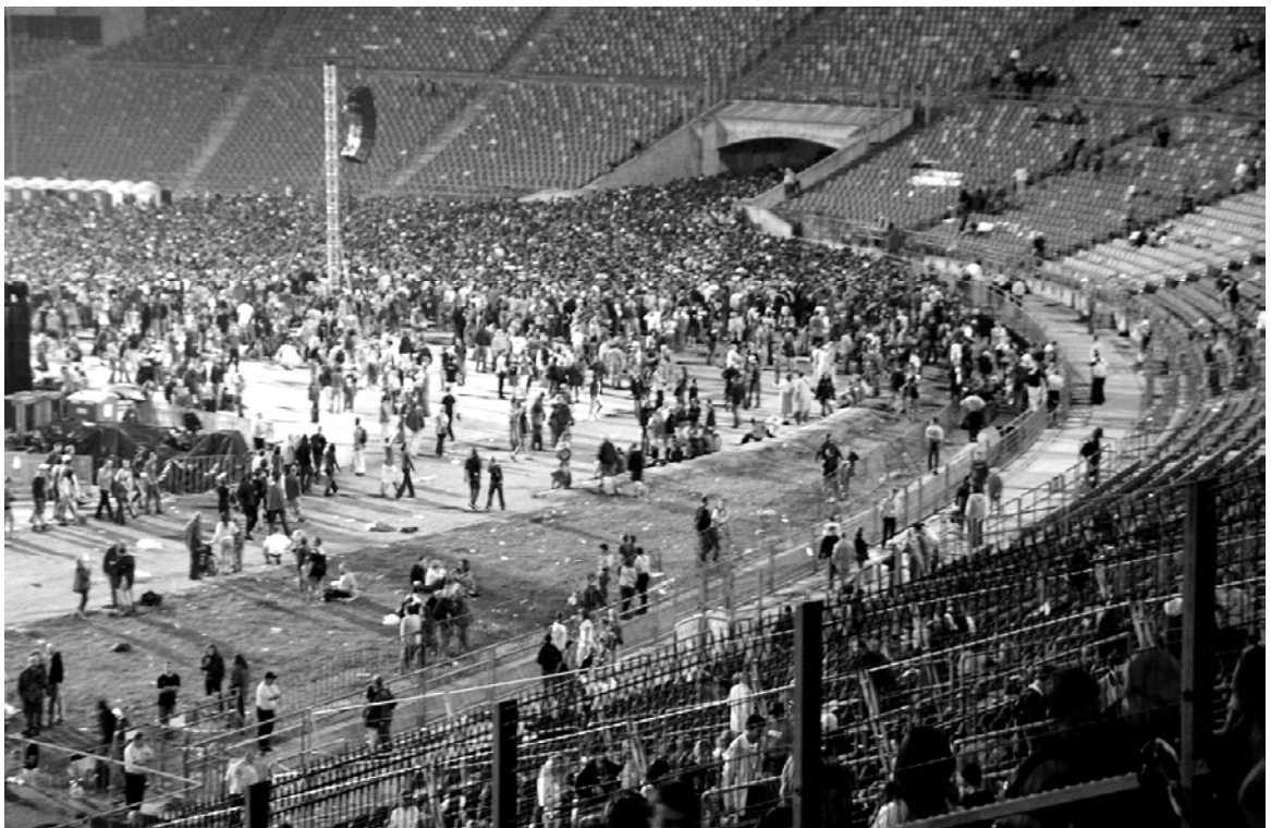
Fot. 4-5. Stadion Śląski – fragment areny, tunel południowy. Końcowa faza opróżniania płyty areny po zakończonym koncercie. Pojemność areny dla funkcji koncertowej wynosi 15-20 tys. osób. Uzyskanie normatywnego czasu ewakuacji (5-8 minut) wymaga uruchamiania wspomagających tunele dodatkowych dróg komunikacji za pośrednictwem pomostów nad fosą i korytarzy widowni. Foto: autor.
