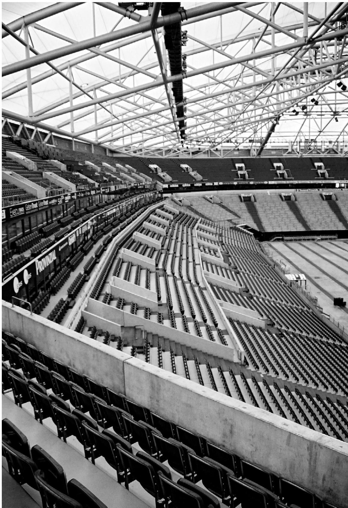
Fot. 2-6. Stadion Veltins – Arena, dawniej Arena AufSchalke, Gelsenkirchen, (2001). Przykład widowni prostokątnej wielokrotnie łamanej (co jeden sektor) o profilu prostoliniowym wielokrotnie łamanym. Dzięki częstotliwości łamania linii rzędów i linii profilu rozwiązanie to posiada cechy zbliżone do widowni łukowej o profilu krzywoliniowym. Cechą wyróżniającą tę widownię jest duże nasycenie wómitoriami, przy znacznych szerokościach korytarzy południkowych.
