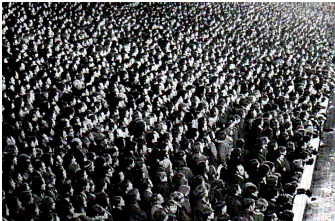
Fot. 2-1. Stadion Anfield Road, Liverpool (1947). Przykład widowni o zbyt małym przewyższeniu linii widzenia fokusu. Widoczne, charakterystyczne dla takich przypadków, zjawisko odchylania do tyłu głów przez większość widzów. Foto: kadr z reprodukcji – za A. Spampinato, Stades-Sport & Architecture de Monde , Tectum, Antwerpen 2004, s. 17.
