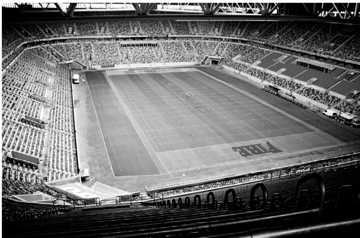
Fot. 2-4. Stadion LTU Arena , Düsseldorf, (2005). Przykład widowni prostokreślniej o profilu prostoliniowym. Linie rzędów widowni przebiegają równoległe do linii bocznych boiska. Ustalona pozycja siedziska, oś anatomicznego pola widzenia jest prostopadła do zewnętrznych krawędzi pola gry. Obiekt należy do nielicznej grupy europejskich stadionów z otwieranym dachem nad areną. Foto: M. Pelczarski.
