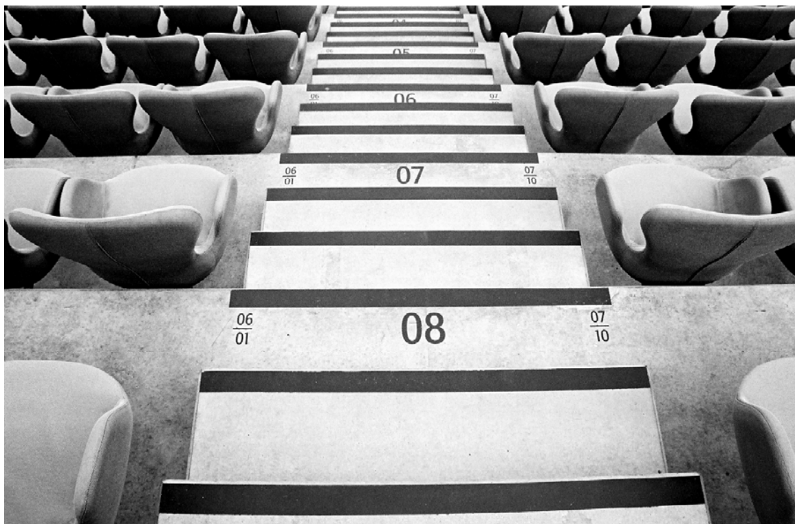
Fot. 3-2. Allianz Arena, Monachium (2006) – fragment widowni, widok z góry. Zależności przestrzenne pomiędzy stopniami trybun i schodami międzysektorowymi. Skrajne siedziska sektorów sytuowane liniowo, równoległe do linii policzkowej schodów.
