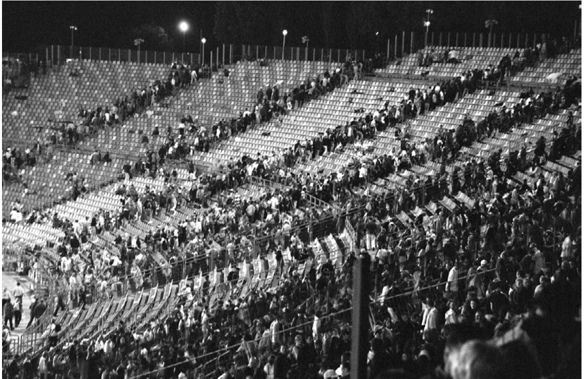
Fot. 4-4. Stadion Śląski – widownia zachodnia. Moment opuszczania trybun po zakończonym koncercie. Parametry dróg komunikacji i ewakuacji w obrębie widowni zapewniają nieprzekraczający pięciu minut czas ewakuacji z każdego sektora. Zdjęcie przedstawia ostatnią fazę opróżniania widowni: puste sektory – stan napełnienia schodów południkowych. Foto: autor.
