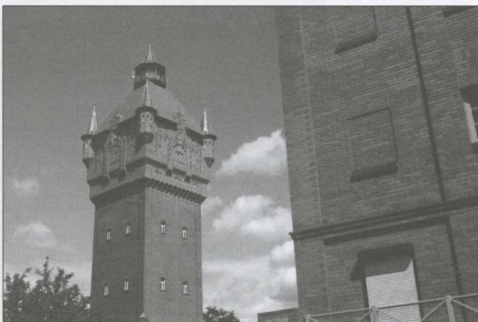
Wieża wodociągowa po remoncie
