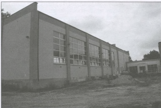
Budowa sali gimnastycznej w Bodzyniewie
