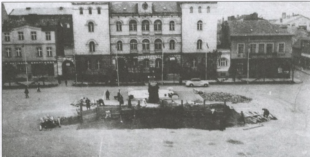
Budowa kulochwytu na Ryнку w Śremie
