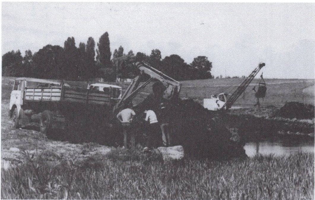
Budowa stawu w Parku XXX-lecia PRL – sierpień-wrzesień 1976 r.
