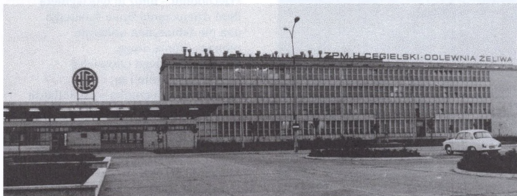
Odlewnia Żeliwa – fronton biurowca i portiernia
