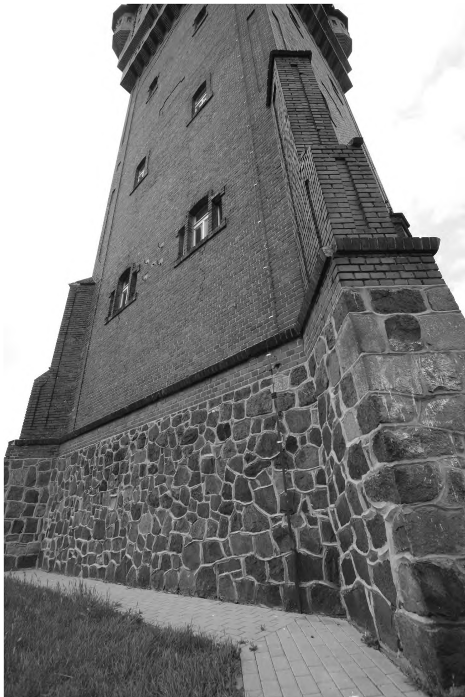
Fot. 2. Wieża ciśnień w Śremie
