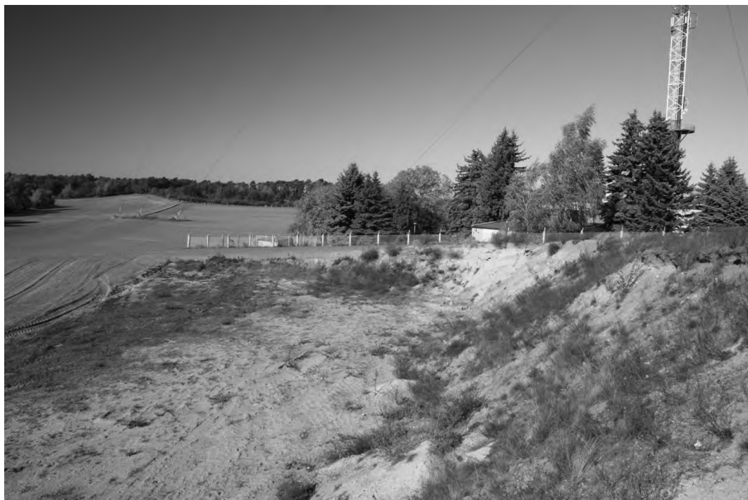
Fot. 1. Wieża radiowo-telewizyjna w Górze na wale ozowym
