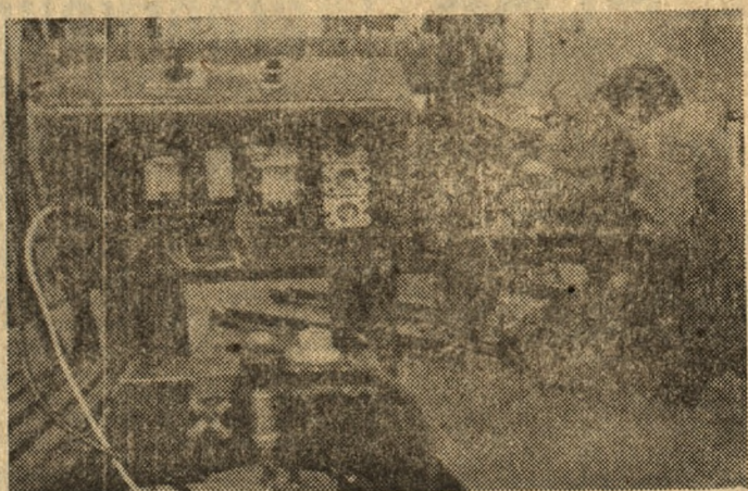
Zakład Doświadczalny przy Instytucie Gospodarki Magazynowej w Poznaniu produkuje w oparciu o własne opracowania prototypy i krótkie serie urządzeń ułatwiających pracę na terenie magazynów. Na zdjęciu: Kazimierz Mikstowski montuje układ elektryczny wózka podnośnikowego z elektrycznym napędem podnoszenia.
