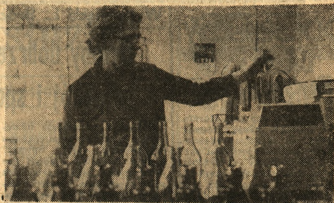
Huta Szkła „Ujście” w Ujściu (Piłskie) produkuje rocznie około 250 mln butelek. Jednym z ważniejszych odbiorców jest polski browar. Nad właściwym przebiegiem procesu technologicznego czuwa zakładowe laboratorium kontroli jakości. Na specjalnej aparaturze bada wymiary, wytrzymałość na temperaturę i ciśnienie. Na zdjęciu: ważenie butelek. Fot. „Głos” — R. Królak
