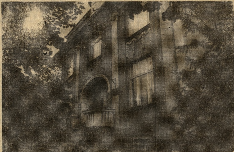
Początkowo Wydawnictwo Poznańskie zajmowało kilka pokoi na I piętrze w domu przy ulicy Franciszka Ratajczaka 35. Od 1965 roku mieści się w stylowym budynku przy ul. Fredry 8. Fot. „Głos” — R. Królak
