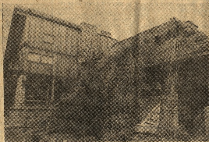
Pisaliśmy ostatnio o decyzjach zlikwidowania trzcinowego poszycia dachów na gościach w Leszczynskim, bo stwarza to duże niebezpieczeństwo pożaru. Prace takie wykonywano przed-wczoraj w zajeździe „Gawra” koło Rydzyny przy trasie E-83.
