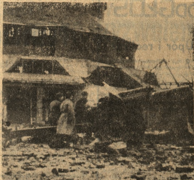
Stanowisko ogniowe artylerii radzieckiej przy Wieży Górno- śląskiej (dzisiejszy Pawilon Centralny) na terenach MTP w lu- tym 1945 roku.
