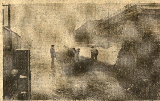
Trwa budowa „trasy niestachowskiej”. Mimo niesprzyjającej pogody, wykonuje się kolejne prace. Wczoraj ekipy Rejonu Budowy Dróg i Mostów pokrywały asfaltem nawierzchnię ul. Żeromskiego w okolicy spółdzielni „Sino”.
