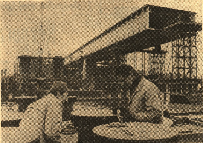
Pierwszy etap budowy Trasy Toruńskiej — kolejnej stołecznej inwestycji komunikacyjnej — to most na Wiśle, który połączy północne dzielnice miasta. Na zdjęciu: spawanie gniazd podpór do przesuwania przeseł mostu.
