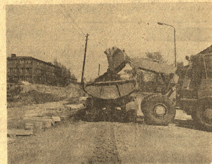
Trwa modernizacja ulic Zeromskiego i Niestachowskiej. Na zdję- ciu: likwidacja skarpy, umożliwiająca poszerzenie ulicy Zerom- skiego.
