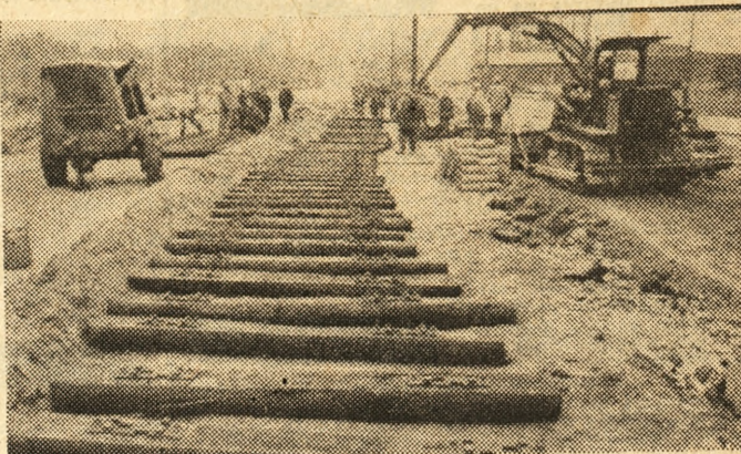
Gdy skończono modernizację skrzyżowania ulic Marchlewskiego, Towarowej i Gwardii Ludowej oraz przebudowę układu torowego w wlotu w tę ostatnią, ekipy budowlane skoncentrowały teraz wysiłek na placu budowy o kilkaset metrów od wspomnianego skrzyżowania.
