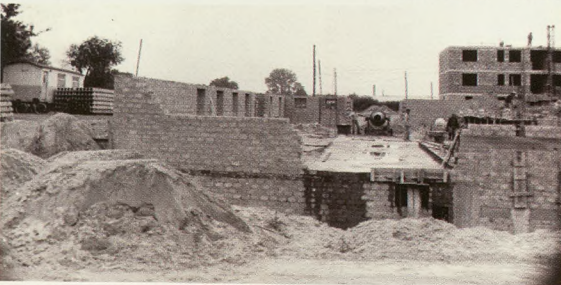
Budowa ośrodka zdrowia w Komornikach i budynek przedszkola w Komornikach - zrealizowane przez spółdzielczą brygadę budowlano-remontową
