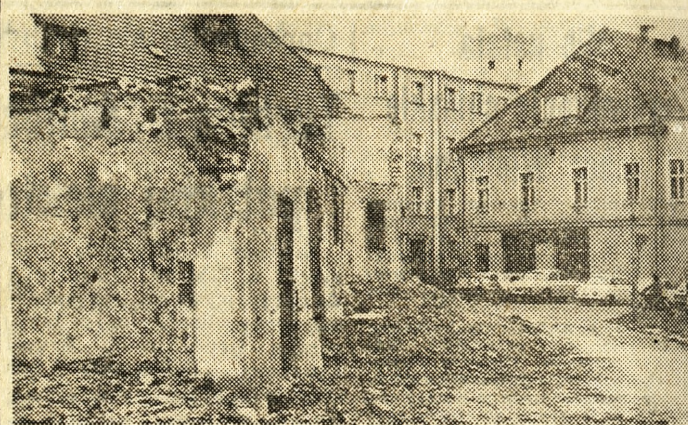
W Sycowie (województwo kaliskie) po rozbiórce — widocznych na zdjęciu — pozostałości starego budynku zostanie w tym miejscu zbudowany dom towarowy.
