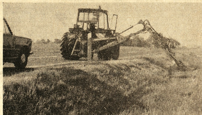
Rejon Dróg Publicznych w Kościanie (Leszczyńskie) do koszenia trawy z pobocza używa kosiarki rotacyjnej ze specjalnym wycią- giem. Na zdjęciu: porządkowanie pobocza drogi do Leszna. Fot. — R. Królak
