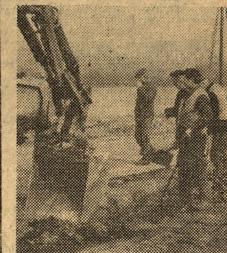
Pobocza wielu dróg w Leszczyńskim przechodzą obecnie modernizację. Na ogół w terminie krótszym niż się planuje. Na zdjęciu: roboty wzdłuż drogi Gostyni — Borek.
