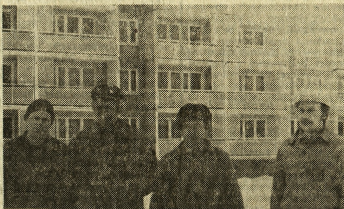
Załoga Poznańskiego Kombinatu Budowlanego wyróżniła się przy budowie bloku 5 w Piątkowie E, któremu przyznano tytuł „Dom z jedyneką”. Na zdjęciu kilku spośród nagrodzonych członków załogi budującej ten dom. Stoją od lewej: Stanisław Kolaszewski (posadzkarz), Henryk Bielawski (betoniarz), Stefan Korzuba (szklarz) i Stanisław Puchalski (montażysta).
