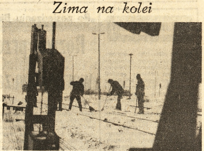
Do Dyrekcji Rejonowej PKP w Zielonej Górze należy środkowy odcinek Odrzańskiej Magistrali Węglowej. Podczas trudnej tegorocznej zimy na tym ważnym szlaku kolejowym pracuje kilkuset kolejarzy i żołnierzy Śląskiego OW. Na zdjęciu: odśnieżanie zwrotnic na stacji towarowej w Czerwieńsku. CAF — fot. Gawalkiewicz
