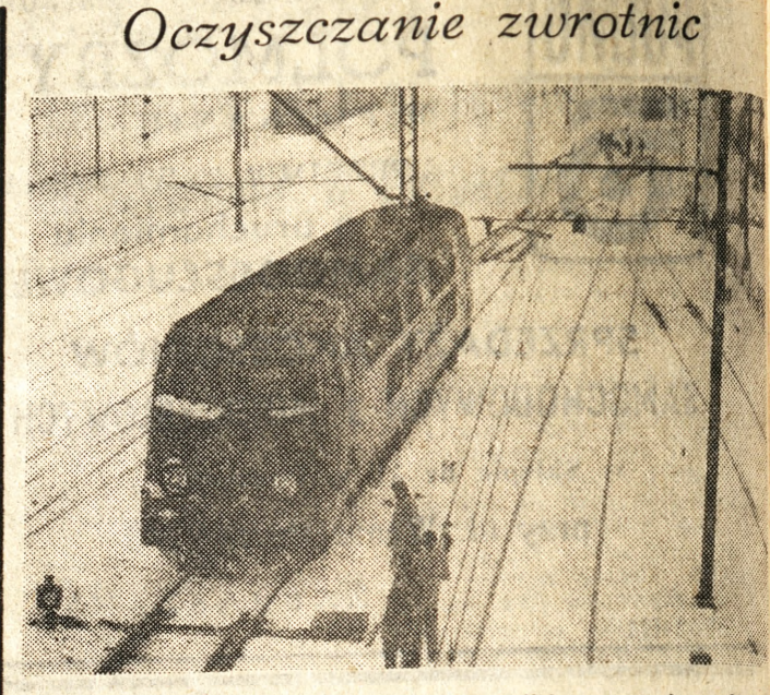
Na szlakach kolejowych trwa usuwanie skutków mrozu i opadów śnieżnych. Zdjęcie ukazuje czyszczenie zwrotnic na torach Węzła PKP w Poznaniu. Fot. — S. Ossowski
