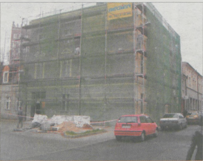
Remont kamienicy przy ul. Kilińskiego 5 znacznie się przedłuża.
