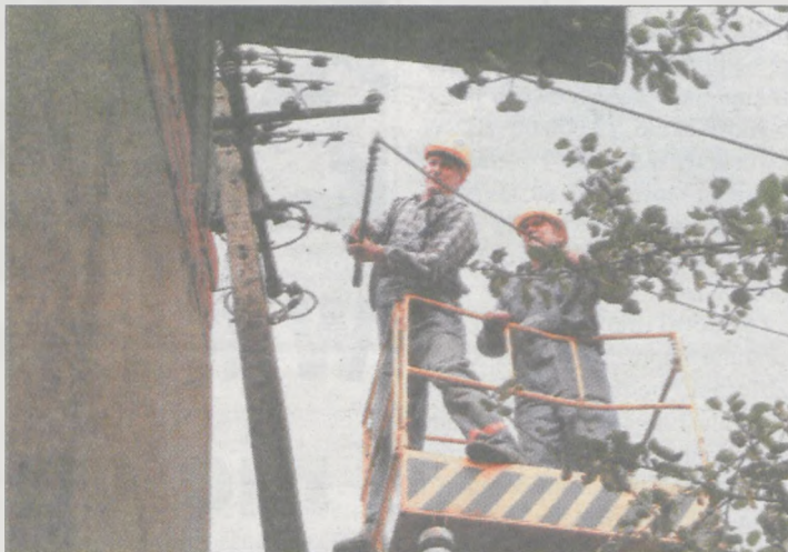
W ubiegłym tygodniu zakończyła się przebudowa linii energetycznej, która od ponad dwudziestu lat straszyła mieszkańców domu w Brodowie.
