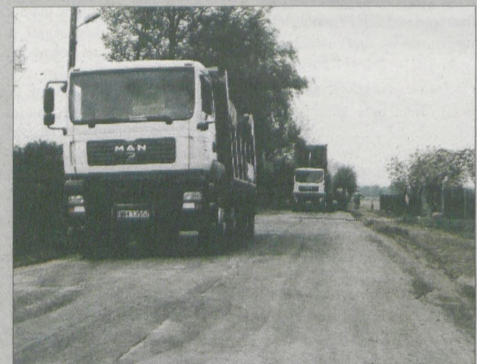
Trwa układanie nawierzchni na drodze w Borzejewie. To jeden z ostatnich odcinków, które autostrada wykonuje na terenie gminy Dominowo. (si)
