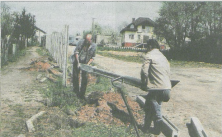
Plot budowany przez pracowników Art-Betu powstanie w ciągu paru dni.
