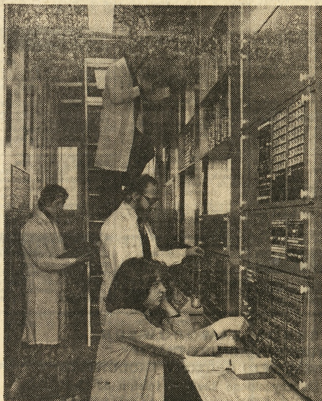
Niedawno uruchomiona została pierwsza w Warszawie centrala telefoniczna typu „Pentacenta”, wyprodukowana przez stołeczne Zakłady Wytwarzania Urządzeń Telefonicznych na licencji francuskiej. Będzie ona obsługiwać 4000 abonentów na osiedlu Stulecie III.
