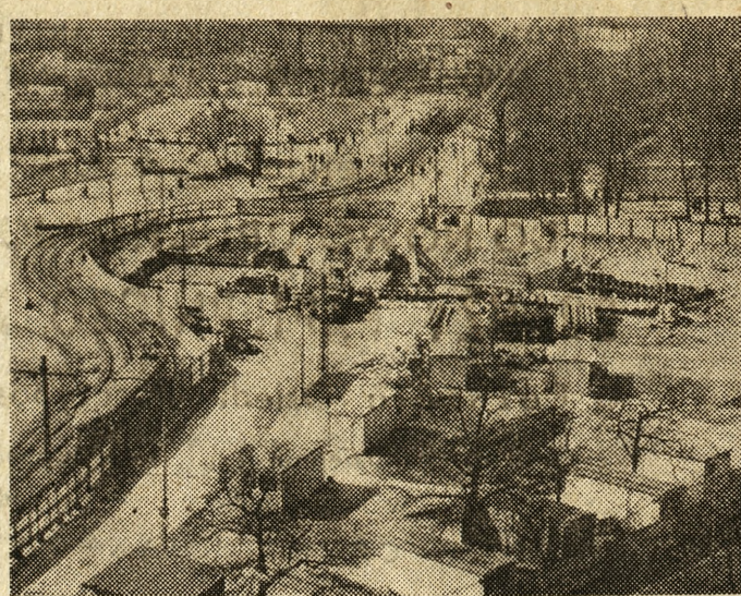
Tak wygląda z okien hotelu „Poznań” plac budowy podziemnego przejścia u zbiegu ulic Marchlewskiego i Gwardii Ludowej. Fot. — R. Królik
