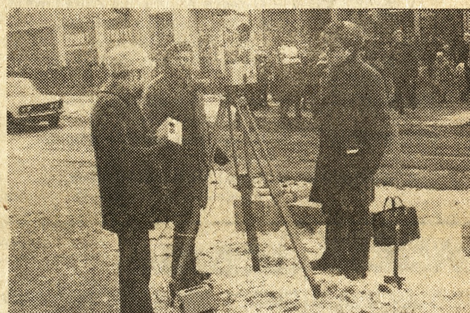
Pracownicy Poznańskiego Przedsiębiorstwa Geodezyjno-Kartograficznego fotografują fragmenty budynków przy ulicy Czerwonej Armii. Na podstawie tych zdjęć zaprojektuje się nowe elewacje domów.
