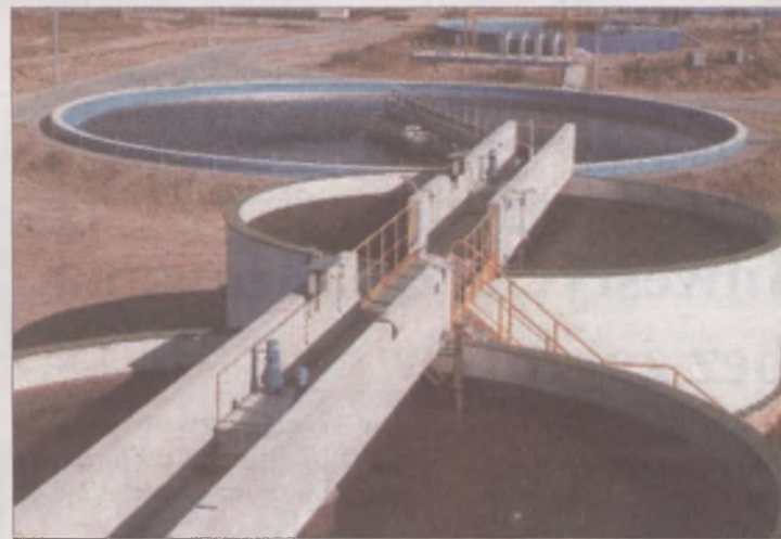
Widok ogólny oczyszczalni z dachu budynku pras.
