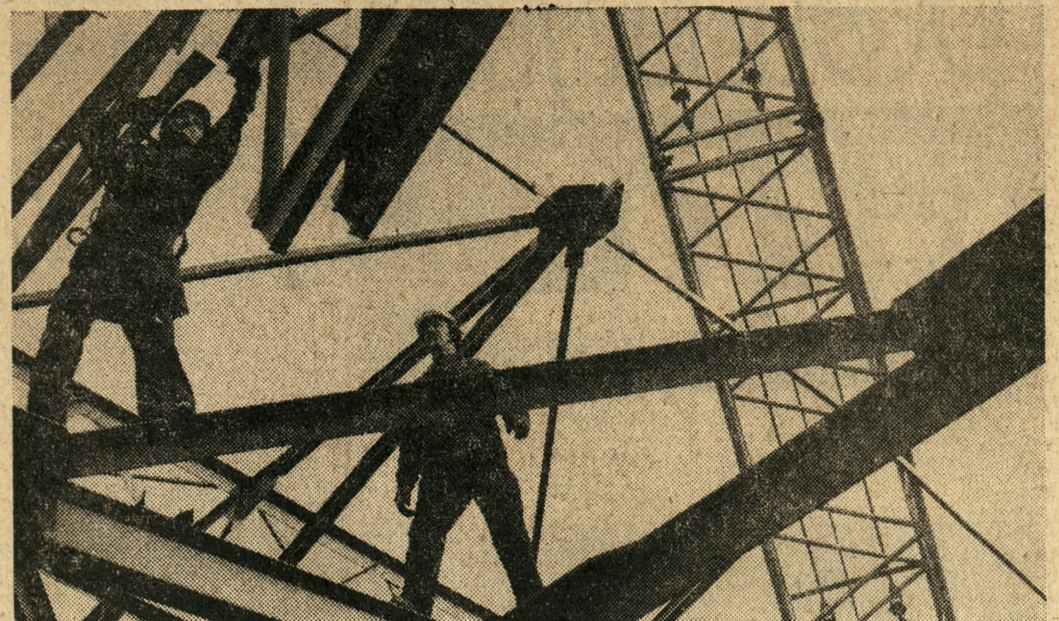
Na terenie budowanej bazy przeładunku surowców chemicznych „Świnoport III” brygady „Mostostalu” z Poznania montują konstrukcje nośne szkieletu dachowego. Przykryje on olbrzymi magazyn o długości ponad 250 metrów. Roboty prowadzone są w ciężkich warunkach — panujące nad Bałtykiem jesienne sztormy utrudniają pracę budowlanych. Na zdjęciu: montowanie konstrukcji przez załogę poznańskiego „Mostostalu”. CAF — fot. Undro
