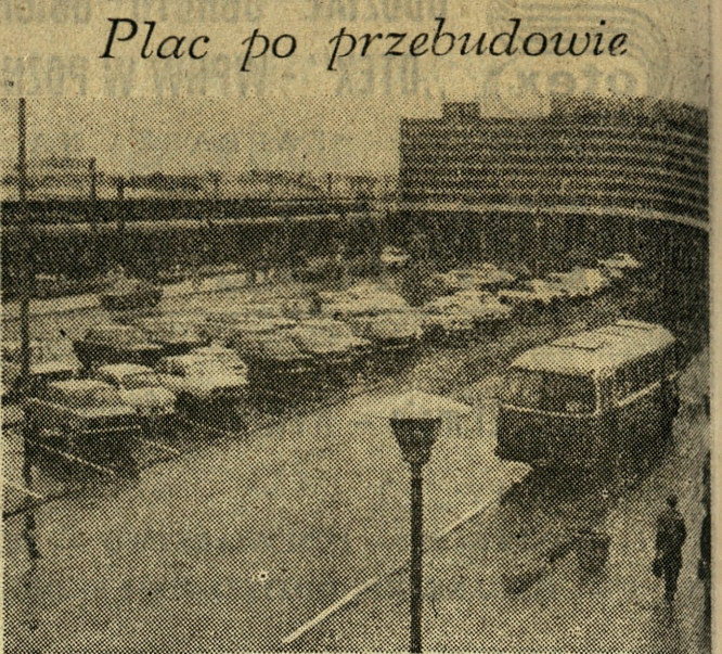
Po kilkumiesięcznej modernizacji, zmienił się wygląd placu przed Dworcem Głównym PKP. Jego układ komunikacyjny jest teraz nowocześniejszy i umożliwia dogodniejszy ruch w tym rejonie. Na parkingu na środku placu zainstalowano osłonięte parkometry.
