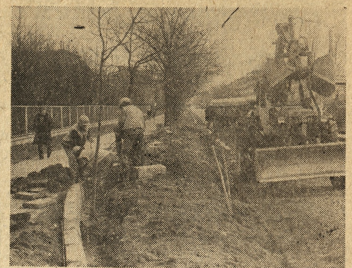
Trwa modernizacja ulicy Swierczewskiego. Na zdjęciu: brygada Stefana Granatowicza z Rejonu Budowy Dróg i Mostów przy urządzaniu nowej zatoki autobusowej.
