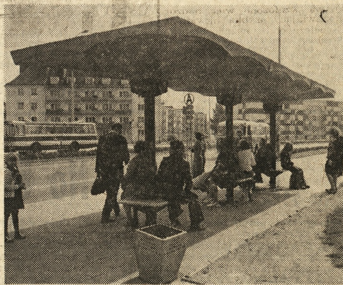
W Pile na wszystkich przystankach komunikacji miejskiej ustawiono kolorowe wiaty chroniące przed deszczem.
