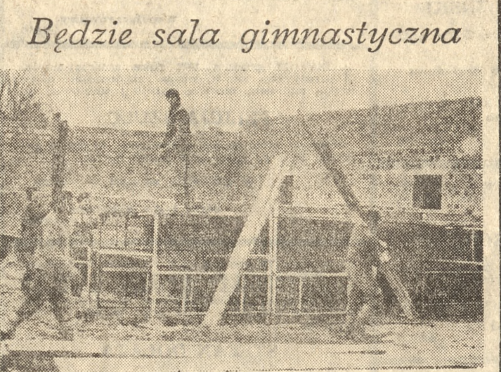
Trwa budowa sali gimnastycznej w Opalenicy (województwo po- znańskie). Służyć ona będzie młodzieży Szkoły Podstawowej nr 2, sportowcom oraz pracownikom Spółdzielni Inwalidów „Chemas”, przeprowadzającym zajęcia rehabilitacyjno-lecznicze. (za) Na zdjęciu: podczas prac na budowie sali. Fot. — H. Kamza
