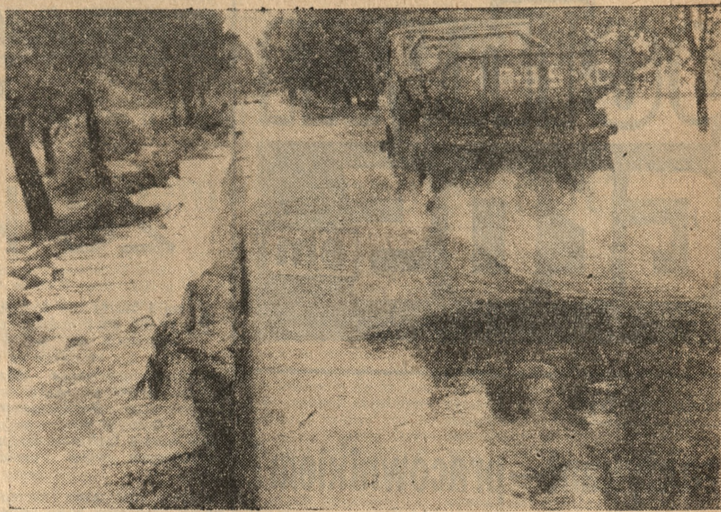
Tak wyglądało na terenach dotkniętych tegoroczną powodzią.
