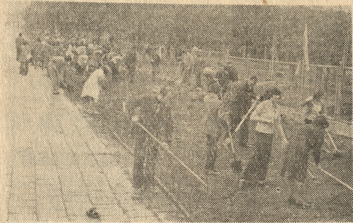
Prace porządkowe wykonywano w Kaliszu także przy al. Niepodległości.
