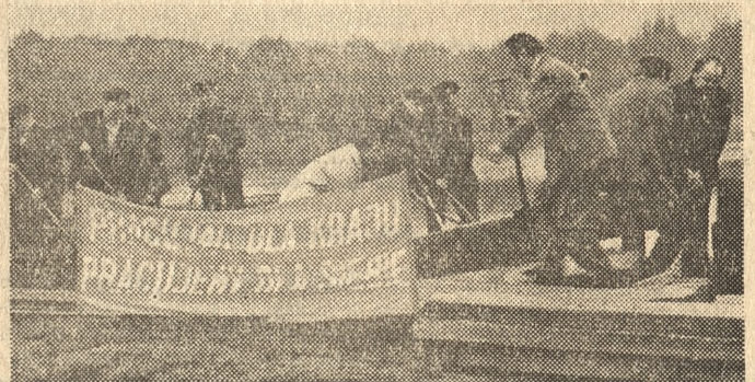
W gminie Krzywiń (woj. leszczyńskie) wykonano prace przy przebudowie drogi z Krzywina do Jerki.
