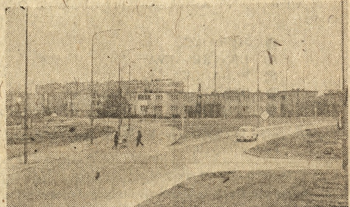
Nowo wybudowany odcinek ulicy Promiennej stanowi dogodnie połączenie Osiedla im. Mikołaja Kopernika z miastem. Fot. — H. Kamza
