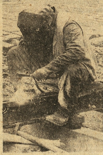
Na zdjęciach: w rejonie ul. Ratajcza przystąpiono do wymiany starego torowiska tramwajowego. Fot. (2) — H. Kamza
