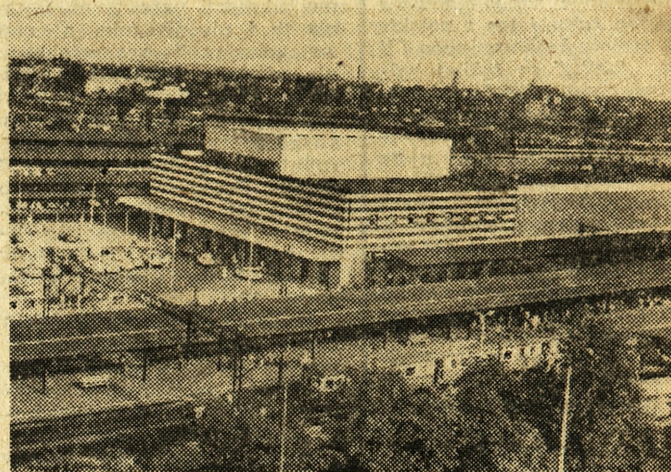
Zakończono prace modernizacyjne gmachu Dworca Głównego PKP w Poznaniu. Z dawnej, twardej bryły z czerwonej cegły, nic nie pozostało. Lekka, utrzymana w jasnej tonacji sylwetka gmachu czyni go nowoczesniejszym. Kolejnym etapem będzie modernizacja wiat peronowych i wejść do tunelów. (za)
