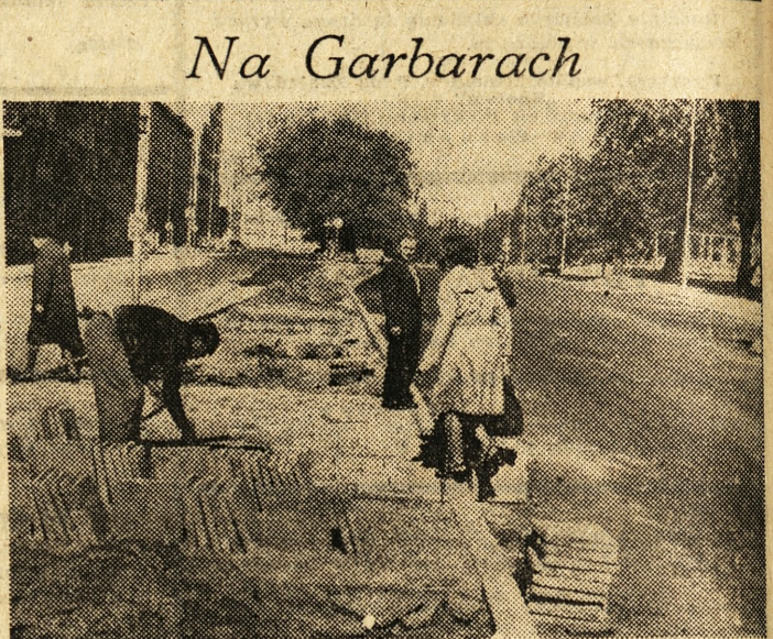
Wkrótce oddany zostanie do użytku zmodernizowany odcinek ulic Garbary — al. Marcinkowskiego. Trwają tam więc teraz ostatnie prace: jeżdżenia otrzymuje lepszą nawierzchnię, układa się chodniki i placówkach „Orbisu” beznadziejnie rozkładają ręce i nie wiadomo nawet kiedy znajdzie się w sprzedaży. (pierwsze partie rozprządano bardzo szybko). Zwożysz, iż numer kolejowej informacji jest przeważnie zajęty, trzeba specjalnie wybierać się na dworzec. Nic przeto dziwnego, że potencjalni podróżni narzekają na ten tajemniczy rozkład. (bop)
