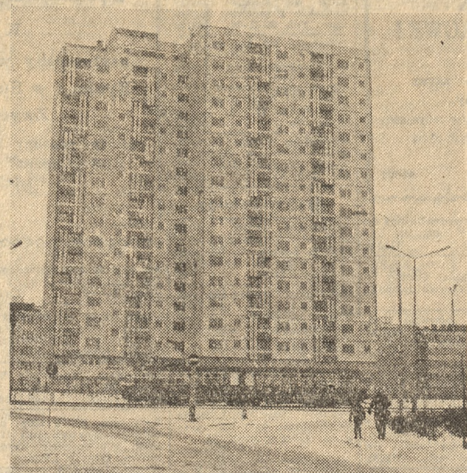
Elekrownie prezentuje się 16-kondygnacyjny dom na Osiedlu Pia- stowskim.
