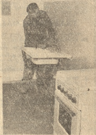
Jan Skrzypczak, monter instalacji sanitarnych, sprawdza działa- nie wyposażenia jednej z kuch- ni „szesnastki”.
