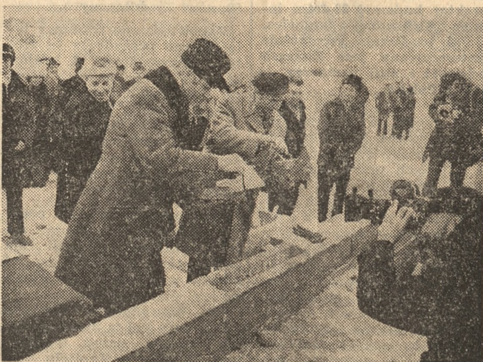
Na zdjęciu: minister przemysłu maszynowego Aleksander Kopeć i I sekretarz KW PZPR w Poznaniu Jerzy Zasada wmurowują kamień węgielny pod budowę hali produkcyjnej.
