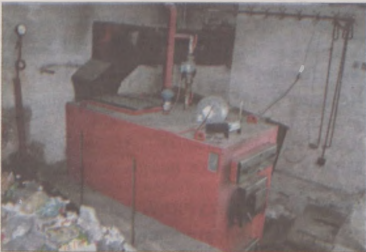
Na zdjęciu - w połowie marca wysiadł dwudziestoletni piec centralnego ogrzewania w GOK-u. Na jego miejscu zainstalowano piec miałowy, a wymiana kosztowała 12.500 zł.
